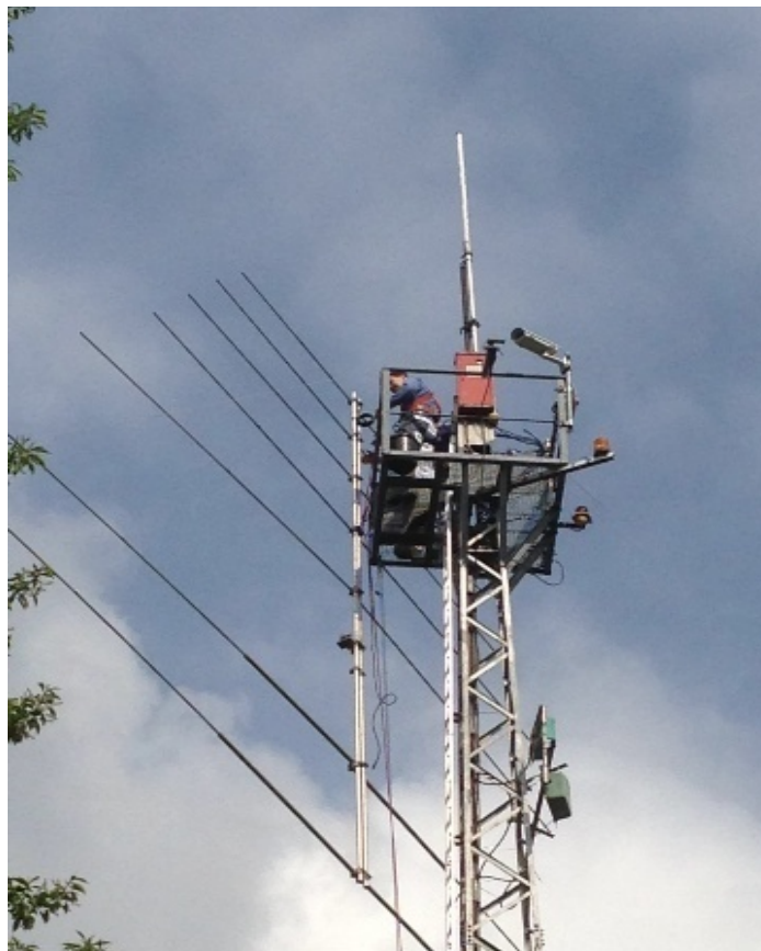
Aufbau einer neuen Antenne auf dem Clubgelände von A05
