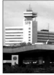
Das Hochhaus des Senders Freies Berlin am Theodor-Heuss-Platz ist Standort des Berliner APRS-Digipeater DBØAJW
