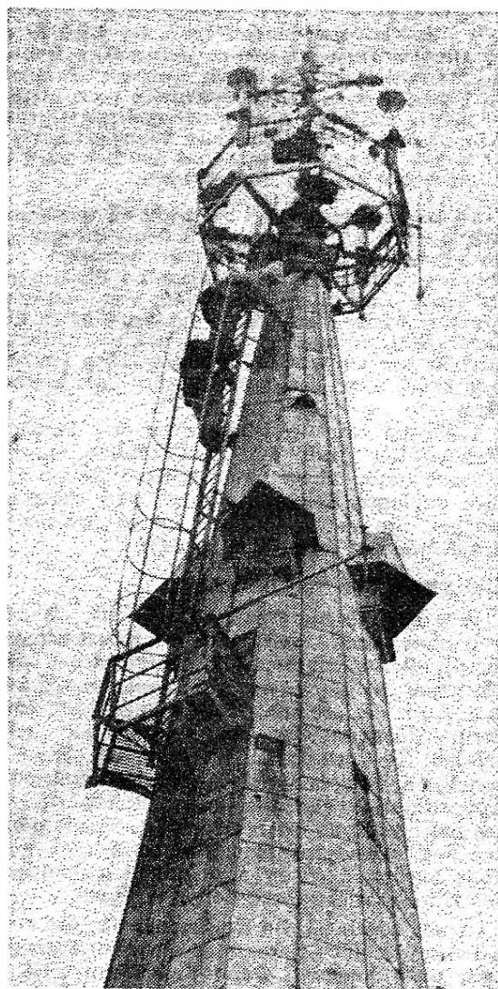
In luftiger Höhe. Auf der Spitze des Turms der Heilandkirche in Moabit ist die Antennenanlage für das UKW-Amateurfunkrelais „DB \phi YL“ montiert. Foto: M. Hoepfner
