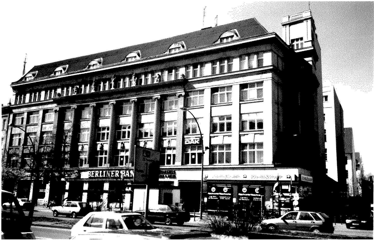
Das „Telefunken“-Haus, Mehringdamm 32 in Kreuzberg
