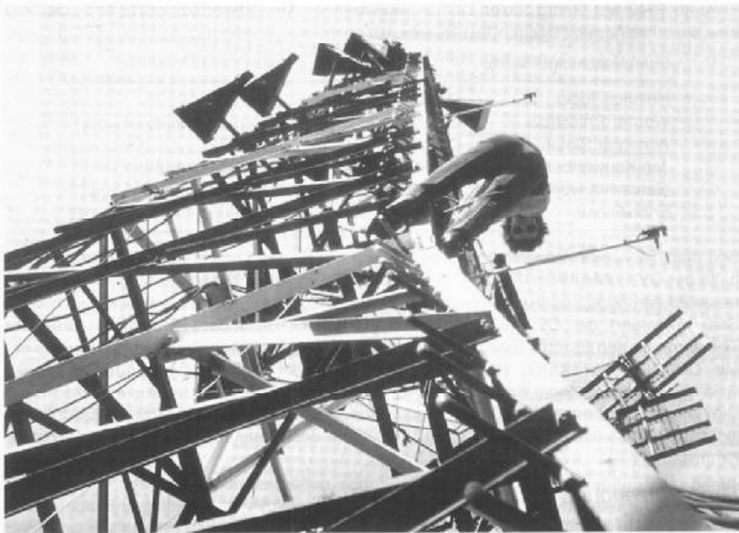
Montagearbeiten auf dem alten Gittermast auf dem Melibokus, der später durch den heute stehenden Betonturm ersetzt wurde. An den Auslegern nach rechts ragend die Antennen der Relaisfunkstelle DB0VD. Bild: OV F42
