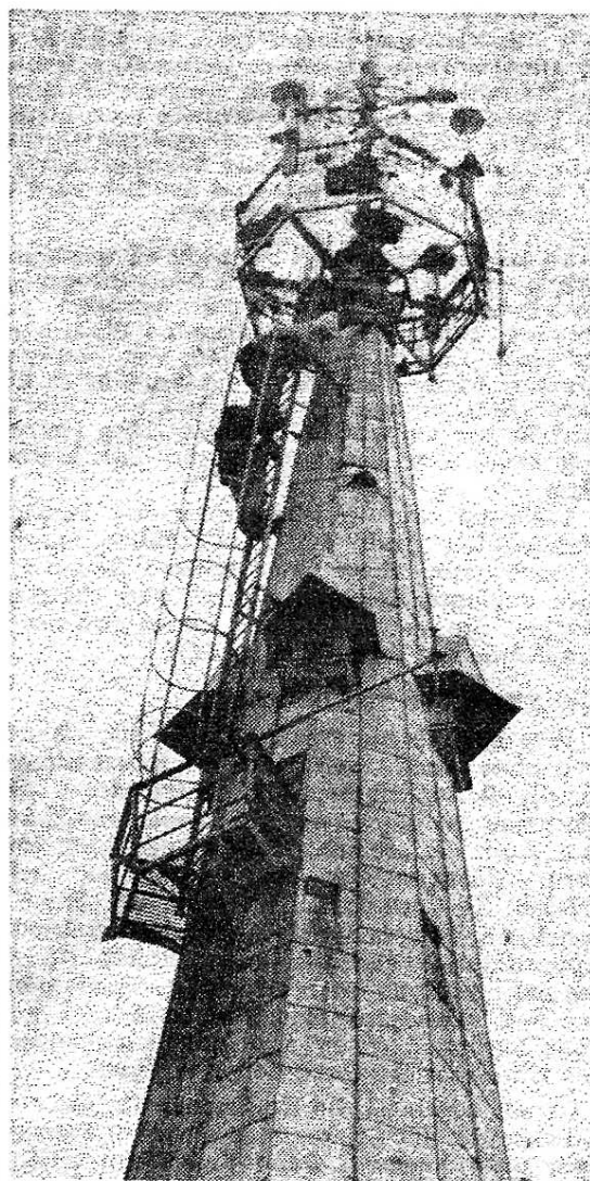
In luftiger Höhe. Auf der Spitze des Turms der Heilandkirche in Moabit ist die Antennenanlage für das UKW-Amateurfunkrelais „DB \phi YL“ montiert. Foto: M. Hoepfner
